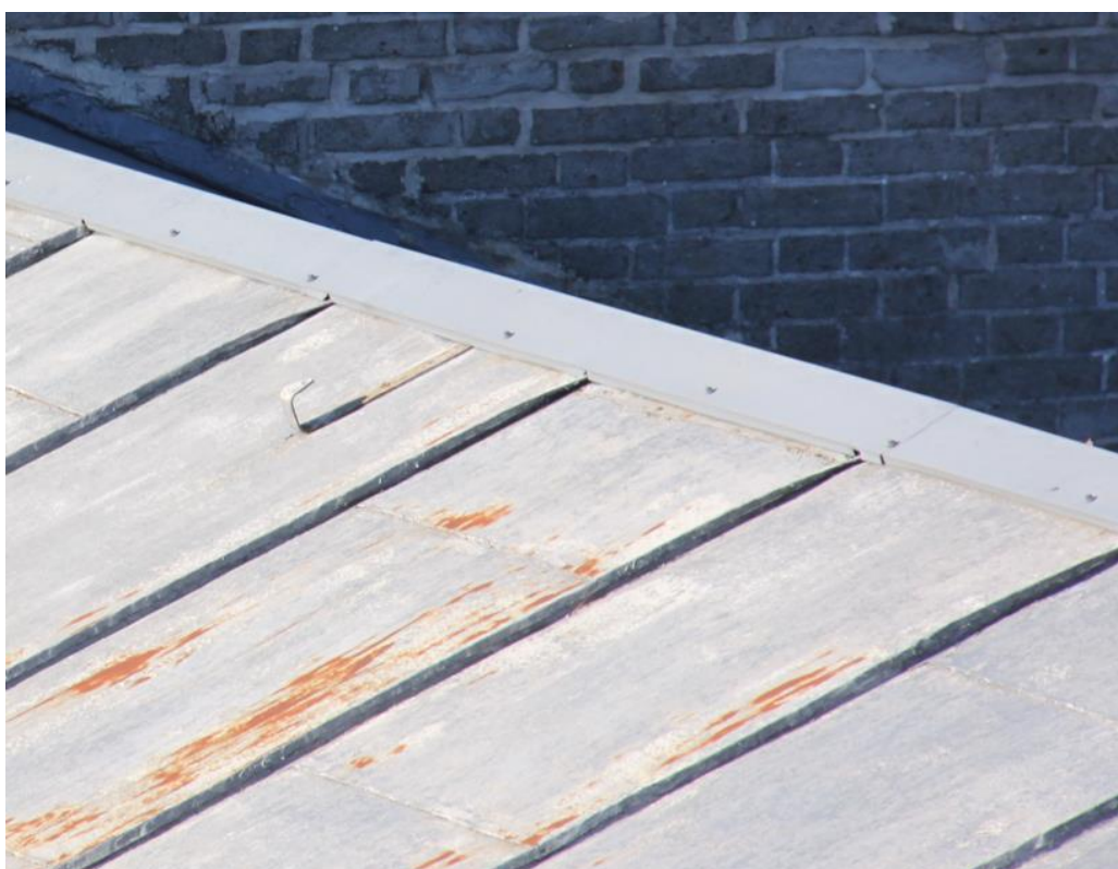
Ślady korozji pokrycia połaci dachowej, brak wentylacji połaci przez gąsiory
