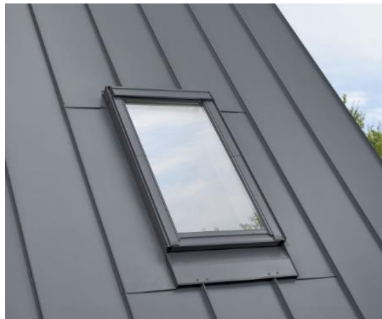
Przykładowy sposób obsadzenia okna połaciowego
