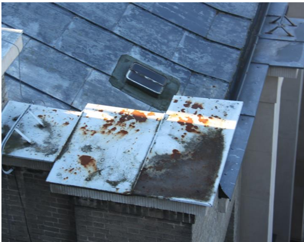
Ogniska korozji na obróbkach blacharskich dachu auli
