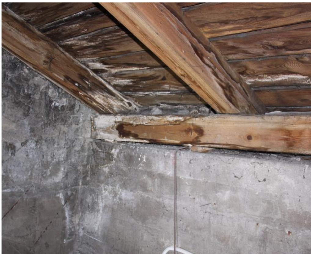
Korozja biologiczna, ślady po zaciekach na drewnianych elementach konstrukcji połaci dachu
