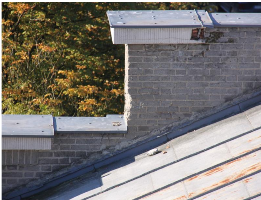
Uszkodzenia muru oraz detalu attyki od strony dachu
