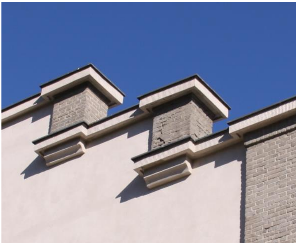
Uszkodzenia muru attyki od strony elewacji południowej
