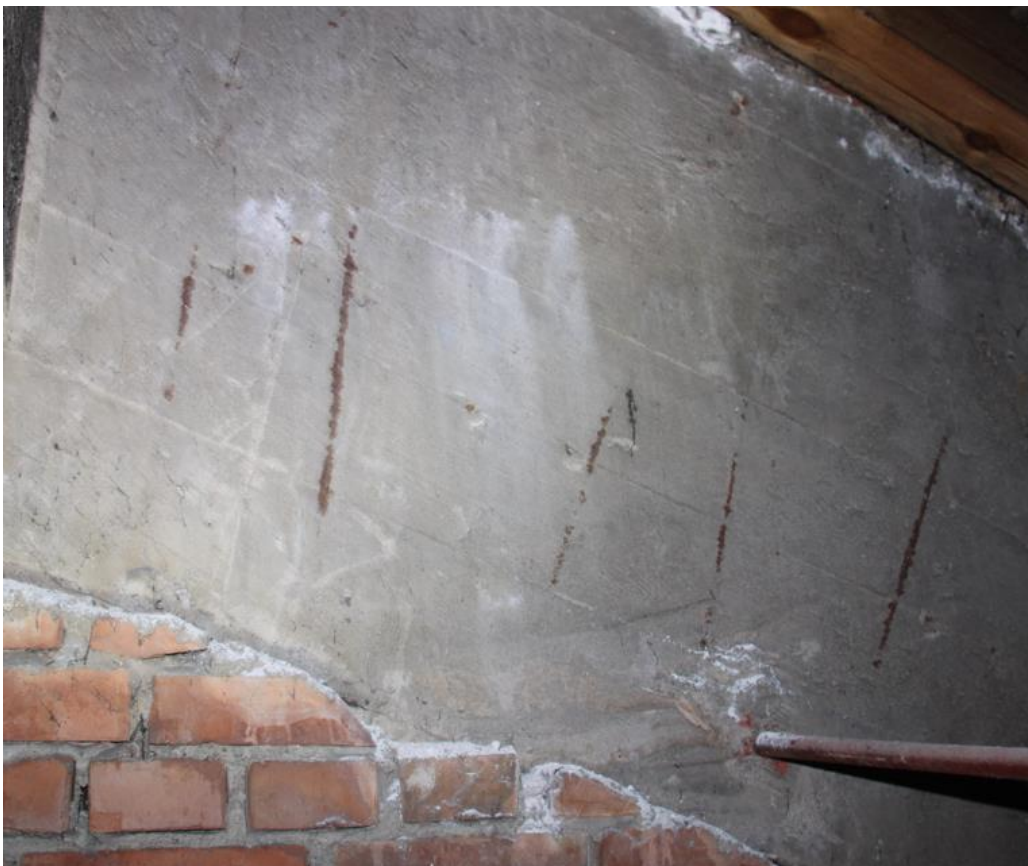
Widoczne pręty zbrojenia elementów żelbetowych konstrukcji dachu auli
